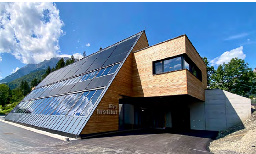
Bio-Institutsgebäude am Moarhof
