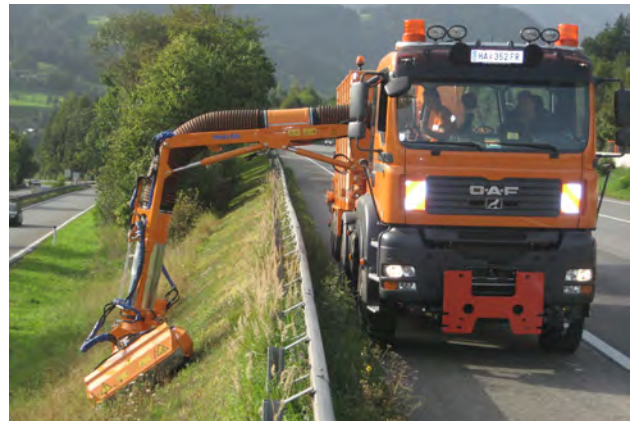
Abbildung 2: Mäharbeiten an der Autobahnböschung
