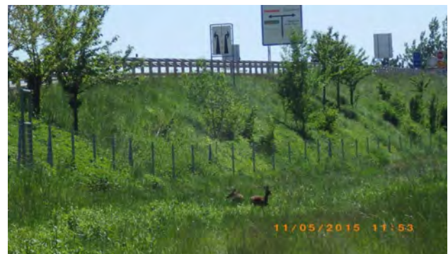
Abbildung 5: Nur durch einen Wildsperrzaun kann Schalenwild von den guten „Äsungsflächen“ an der Fahrbahn abgehalten werden
