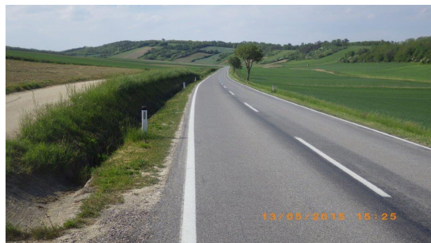
Abbildung 2: Nur durch rechtzeitiges Mähen bleiben die Leiteinrichtungen für den Verkehrsteilnehmer sichtbar
