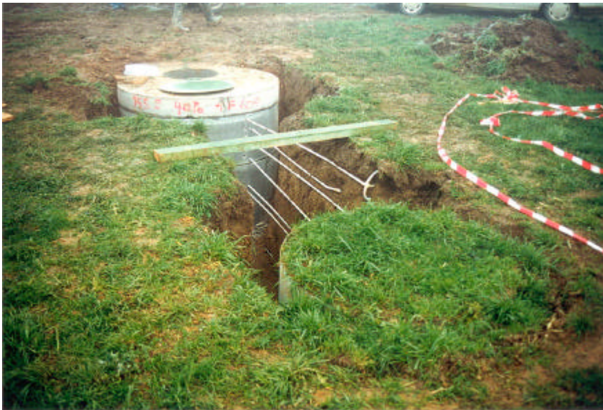
Abbildung 4: Lysimeter des Grünlandstandortes mit Messschacht (vor dem Verfüllen der Baugrube)
