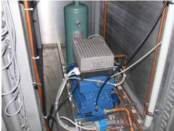
Entfeuchter-Aggregat mit aufgesetztem Frequenzwandler.
