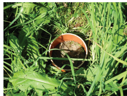
Rohrstutzen zur Durchführung von Bodengasmessungen
