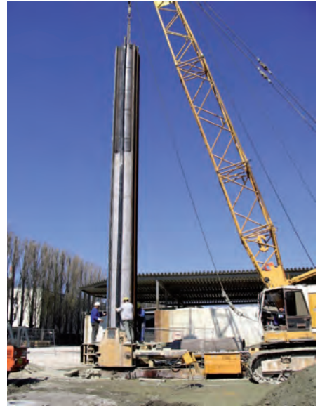
W21: Filterfenster Rohr-Einbau
