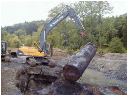
Bergung Öltank Altlast N47
