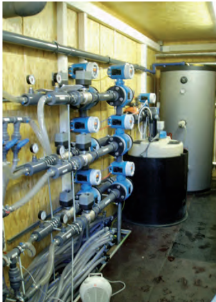
Reinigungsanlage: Aktivkohlefilter (Arbeitsfilter, Polizeifilter), Verrohrung im Container
