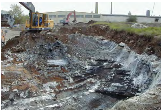
Räumung Altlast N35: Sichtung an Abbaufont
