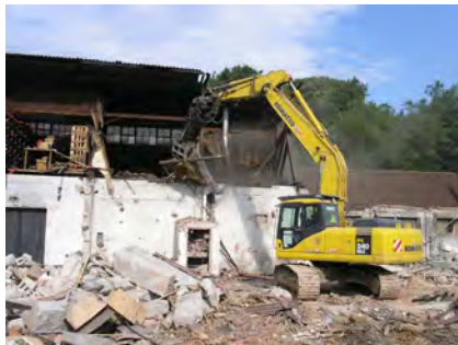
Abbrucharbeiten bei Altlast N47
