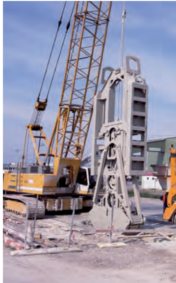
Altlast W21: Schlitzwandgreifer
