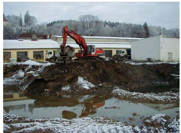
Aushub bei Altlast N47
