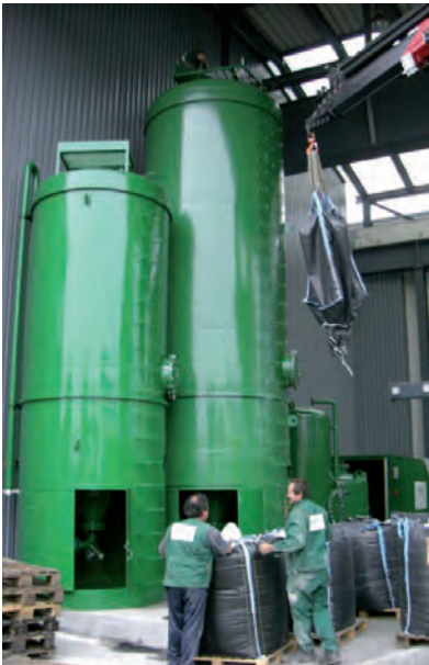
Reinigungsanlage: Aktivkohlefilter (Arbeitsfilter, Polizeifilter), Verrohrung im Container
