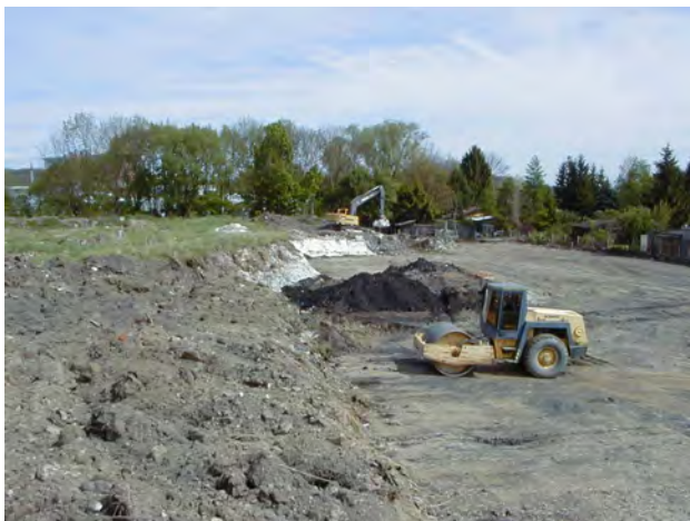
Räumung Altlast N35: li: Abtrag + re: Wiedereinbau
