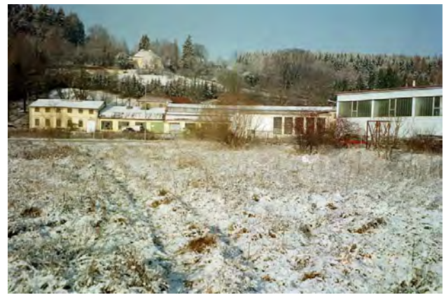
Vordergrund: Deponie N50, Hintergrund: N47
