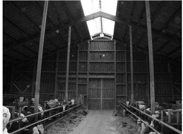
Abbildung 6: Ein ungehinderter Luftaustritt am Lichtfirst ist zu gewährleisten
