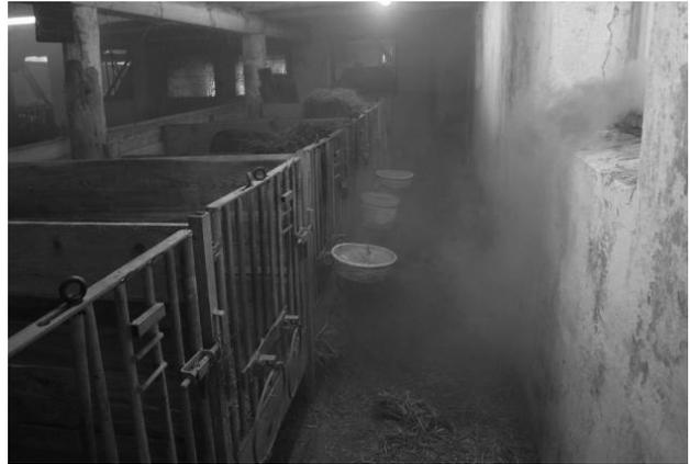
*Abbildung 13:* Durch Nebel deutlich sichtbarer Kaltlufteintrag
