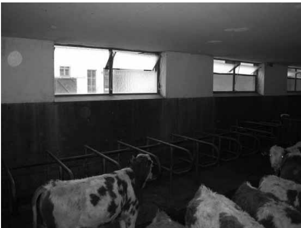
Abbildung 5: Zuluftführende Fenster über den Liegeboxen sind im Winter zu schließen
