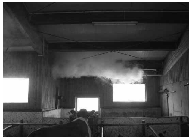
Abbildung 4: Direkter Kaltluftereintrag nur über dem Wartebereich
