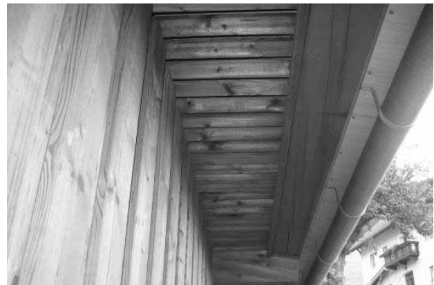
Abbildung 3: Zuluft an der Traufe
