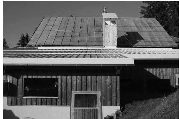
Abbildung 2: Mindestsystemhöhen sind einzuhalten
