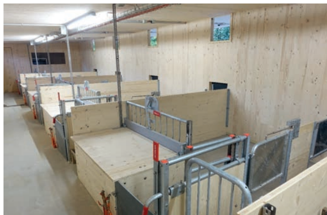
Abbildung 3: Schweineastall aus CLT (Wandstärke 10 cm, 5-lagig; Aufstallung 6 cm, 3-lagig) © Werner Hagmüller
