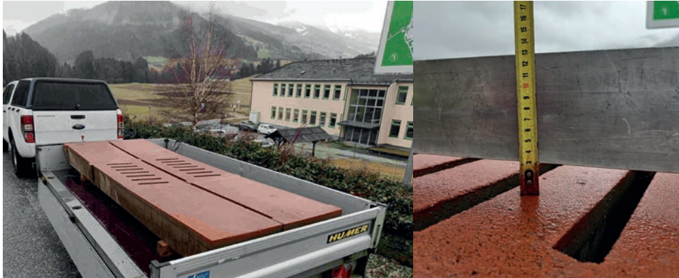
Abbildung 1 und 2: Teilspaltenboden der Fa. Stallit mit 3 % Gefälle zu den Spalten (© HBLFA)
