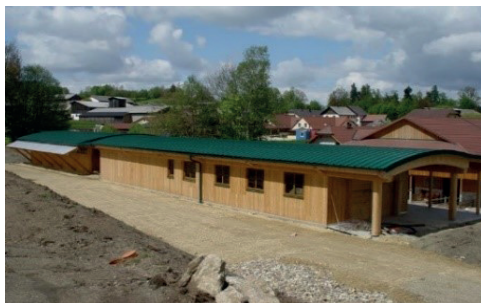
Abbildung 2: Stallgebäude aus CLT (© Holzbau Rast & Ruh GmbH)
