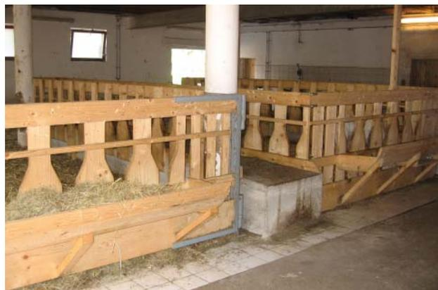
*Foto 1: Umgebauter Rinder-Liegeboxenlaufstall für Ziegen mit Futtertisch und Stichgängen*
