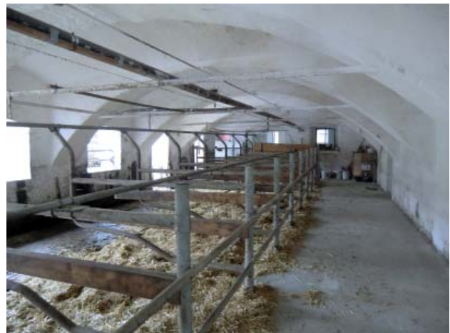
Abbildung 2: Eingestreuete Liegeboxen in einem für Milchvieh adaptierten, einreihigen Laufstall. Anfall von Gülle mit Strohanteil. Bild Angeringer
