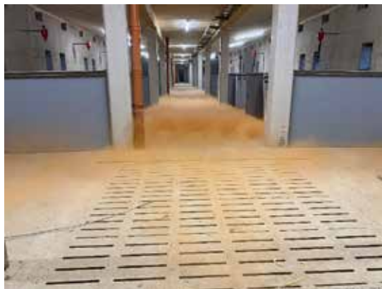
Abbildung 5: Stallinnenraum mit zuluftführendem Kontrollgang, Liegebereich links und rechts mit verschiebbaren Buchtenrückwänden (Quelle: Raumberg-Gumpenstein)
