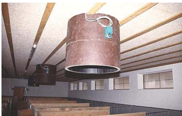
Abbildung 16: Klassische Porendecke mit Heraklith - Holzwolleplatte
