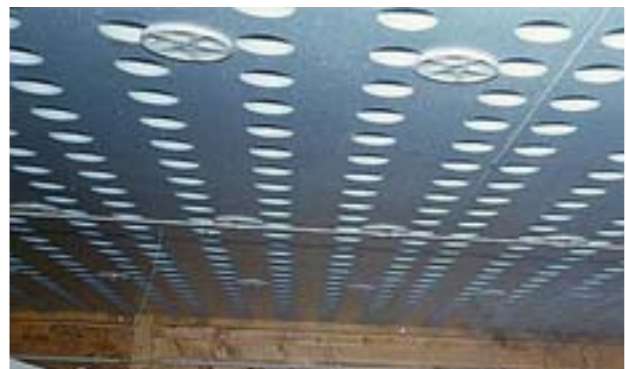
Abbildung 9: Gelochte Kunststoffplatten als Zuluftelement
