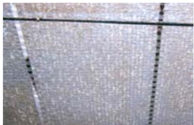
Abbildung 7: Textil- oder Kunststoffgeflecht (ACC) als Zuluftelement
