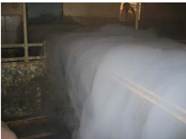
Abbildung 21: Indirekter Falschlufteintrag über eine Unterflur-Betriebsganglüftung
