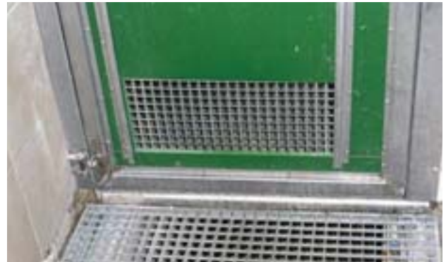
Abbildung 12: Zuluftöffnung in der Abteiltür
