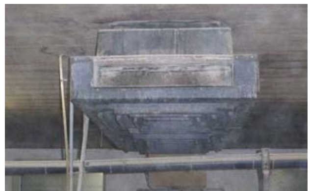
Abbildung 4: Rechteckige Strahl Lüftungseinheit mit Öffnungen in 4 Richtungen
