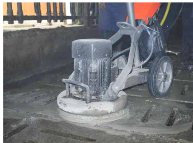
Bild 1: Das Kugelgranulat Scheuern mit der Schleifwirkung zum Sanieren von planen Oberflächen
