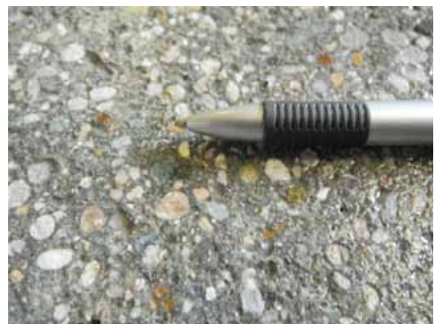
Bild 2: Oberflächenstruktur unmittelbar nach dem „Kugelgranulat Scheuern“
