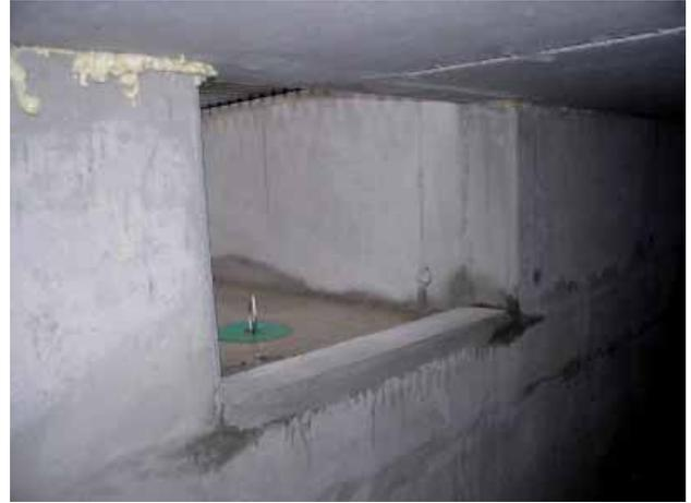
Abbildung 4: Zuluffführung in das Abteil
