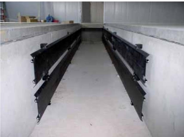
Abbildung 7: Um die Lufttemperatur im Winter über 0°C zu halten, kann durch mit Warmwasser beheizte Wasta-Platten die Zuluft erwärmt werden.
