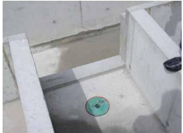
Abbildung 6: Zum Waschen des Zuluftkanals dient die Stau-nase und der Stopfer.
