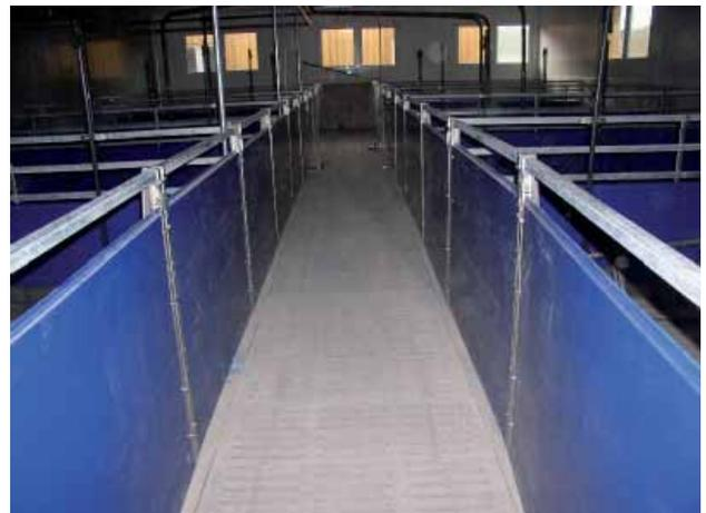
Abbildung 8: Die Luft im Kanal unterhalb des Versorgungsgangs strömt durch den Spaltenboden in das Abteil. Die Buchtenwände müssen dicht sein, damit die die Luft langsam in den Tierbereich gelangt.
