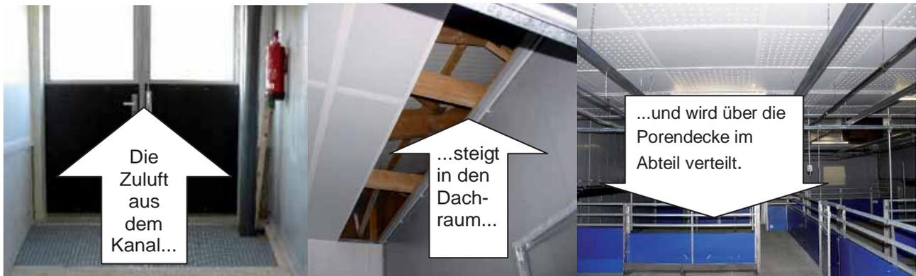
Abbildung 9: Die Zuluft aus dem Kanal steigt in den isolierten Dachraum und gelangt über die Porendecke in den Tierbereich.
