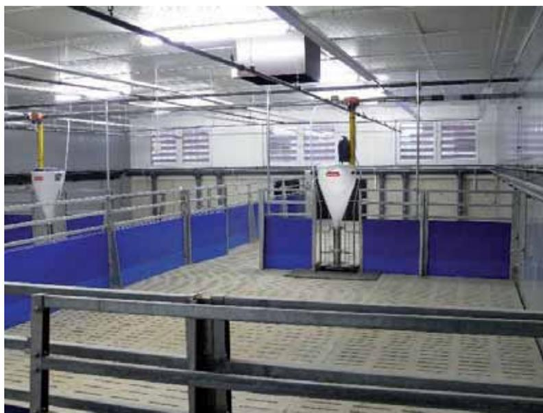
Abbildung 1: Abteil mit karoversetzter Porendecke
