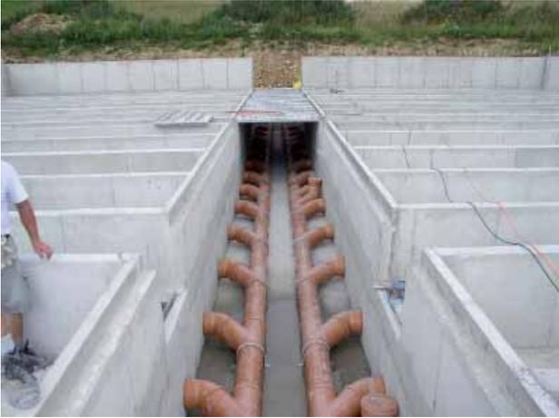
Abbildung 3: Zuluffführung unterhalb des Zentralgangs
