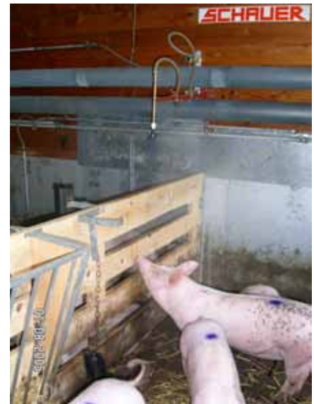
Foto 2: Schweinedusche in Selbstbauweise
