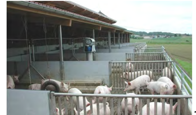
SF+ 11 Betriebe Freie Lüftung, Auslauf
