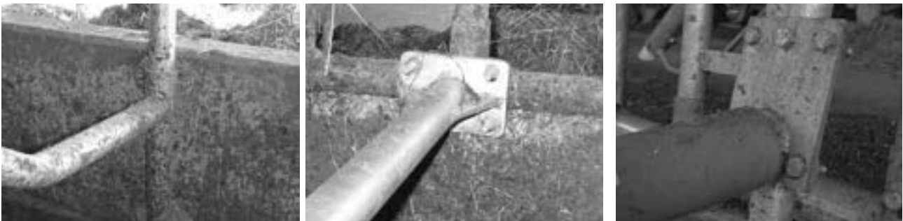
Abbildung 8: Verschiedene Arten von Befestigungsmöglichkeiten von Fressplatzabtrennungen (Bilder: Agroscope)
