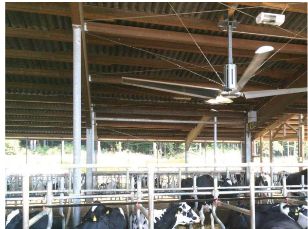
Abbildung 6: Horizontallüfter über gegenständigen Liegeboxenreihen
