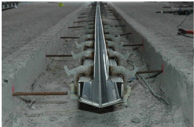
Abbildung 5: Nachträglicher Einbau einer Harnsammelrinne in bestehendem Stall (Bild: Agroscope)
