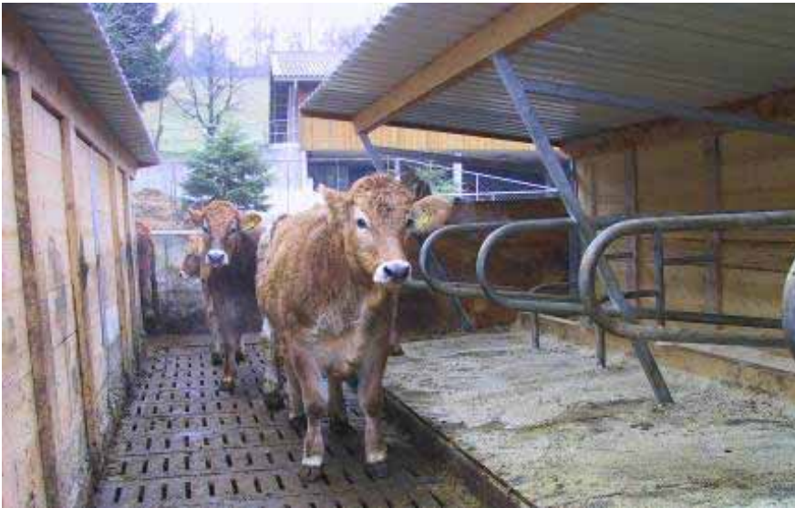
Abbildung 2: Liegeboxenstall in Cuccettenbauweise (Umbaulösung); zu sehen ist eine Liegeboxenreihe und die Rückwand einer parallel dazu angeordneten weiteren Liegeboxenreihe; im bestehenden Stall ist der Fressbereich eingerichtet.
