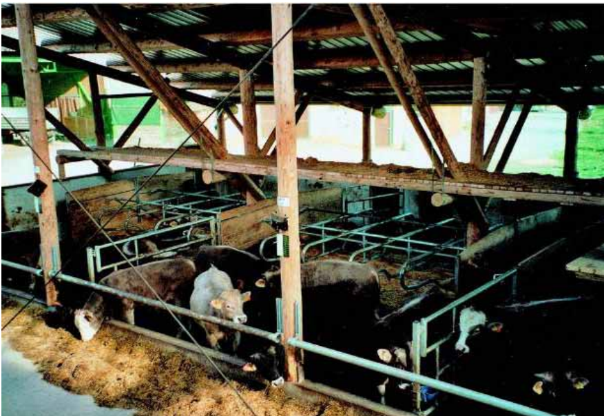
Abbildung 3: Liegeboxenlaufstall für Masttiere als Kaltstall in Rundholzbauweise (Neubau); Offene Bereiche der Bauhülle sind mit Windschutznetzen versehen; der Futtertisch ist beidseitig genutzt; 10er-Gruppen, gegenständige Liegeboxen; Laufbereich als Spaltenboden (Bild: Meliorbulletin Nr. 90).
