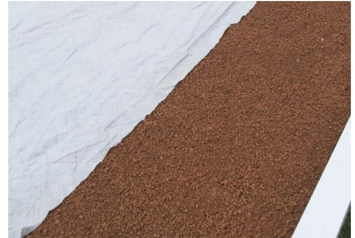
Drainageschicht – Zielsplitt, Filtervliesabdeckung
