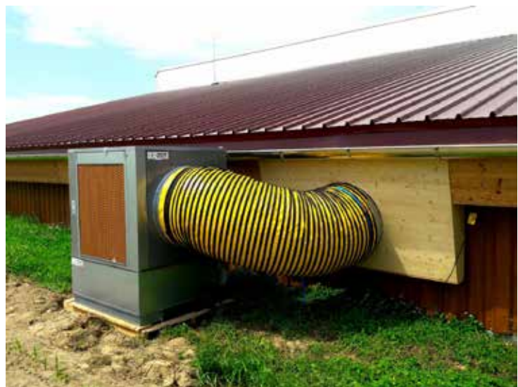
Cool-Pads können relativ einfach in Stallungen integriert werden, um Zuluft zu kühlen Foto: E. Zentner
