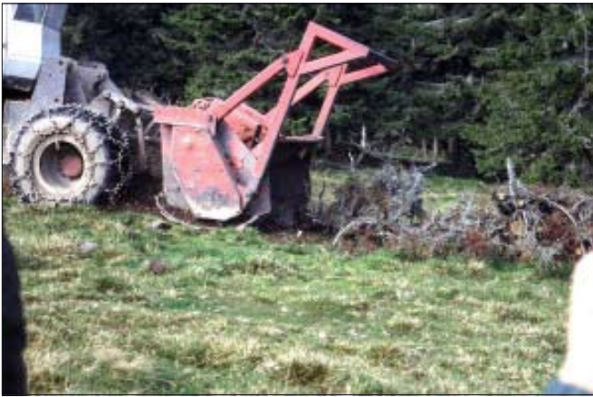
Bild 31: Stockfräse im Einsatz, das Holzmaterial und die Wurzelstöcke werden zerkleinert und in die obere Bodenschicht eingearbeitet
