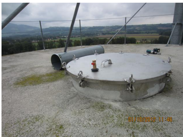
Abbildung 6: Deckel mit Kugelhahnventil und Gärgasmessung mit DRÄGER-Messgerät
