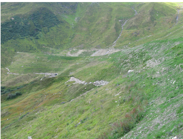
Abbildung 3: Talseitige Böschung des Lawinendammes, großteils begrünt mit Soden aus dem Fassungsbereich
