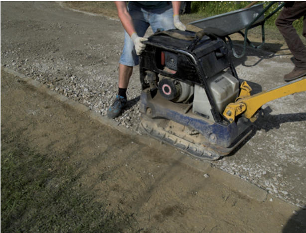
Abbildung 15: Verdichten der Vegetationstragschicht mit Rüttelplatte (Mai 2013)
