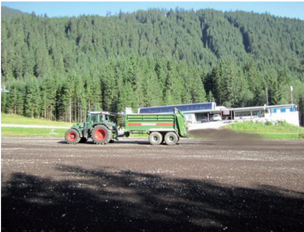
Abbildung 5: Aufbringen des Kompost mittels Kompoststreuer, Schotterrasen Zwieselalm (Gosau, August 2011, Foto Urstöger)
