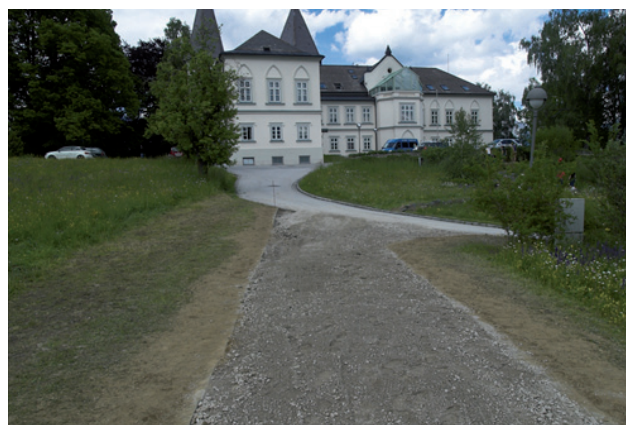
Abbildung 14: eingebaute Vegetationstragschicht vor dem Verdichten (Mai 2013)
