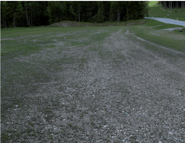
Abbildung 11: stark befahrene Fläche im Vordergrund zeigt eine Vegetationsdeckung von ca. 20%, Schotterrassen Zwiesselalm (Gosau) 2 Jahre nach Anlage (Mai 2013)
