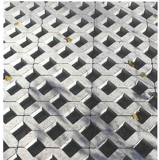
Betongittersteine sind in jedem Baumarkt erhältlich. Ihre Stärke liegt in der hohen Haltbarkeit.
