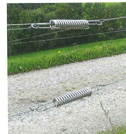
Zug- und Spanneinrichtungen gehören zu jedem Fixzaunsystem dazu.
