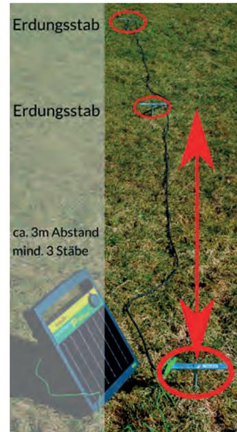
Abbildung 7: Anlage der Erdung
