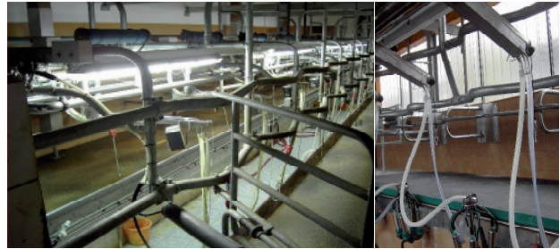
Abbildung 16: tiefe Lampen blendfrei für Mensch und Tier; Fenster, Lichtfirst
