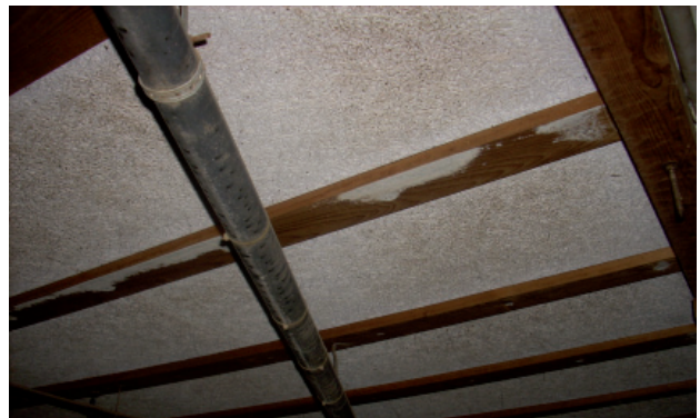
Abbildung 2: Klassische Porendecke (Holzwolleplatte mit Dämmstoffauflage)
