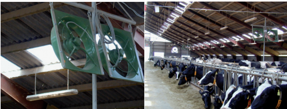
Abbildung 2 und 3: Wurfweiten von Einzelventilatoren und Blockanordnung
