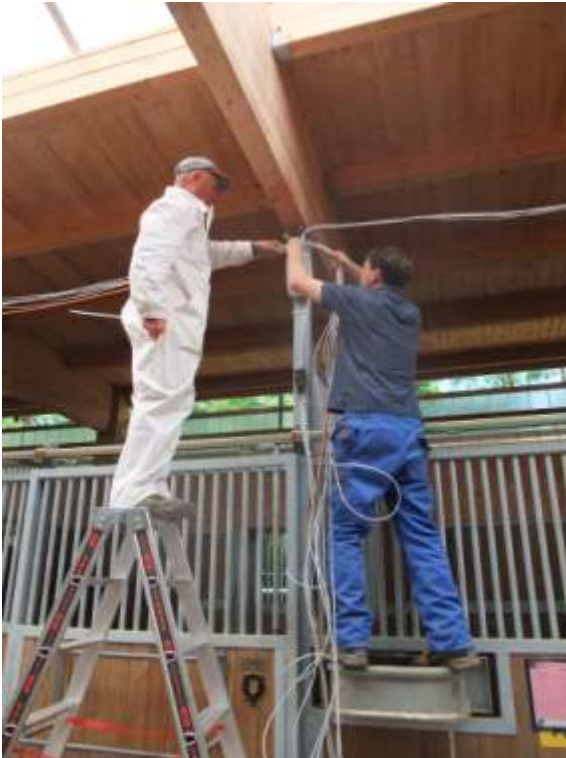
Abbildung: Installation der Videotechnik im Stallbereich
