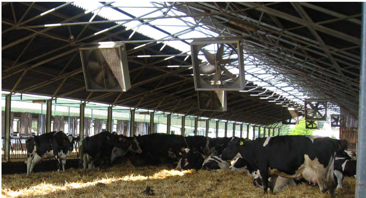
Abbildung 6: Kühlung mit Vertikalventilatoren (Quelle: Peinhopf-Petz)
