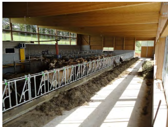
Abbildung 3: Wandständige Liegeboxen auf der linken Bildseite (Quelle: Zentner)
