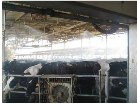
Abbildung 7: Großtropfige Kuhdusche (Quelle: Peinhopf-Petz)
