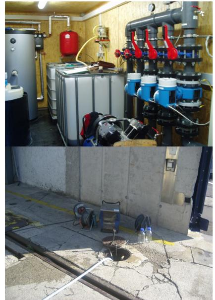
Reinigungsanlage: Aktivkohlefilter (Arbeitsfilter, Polizeifilter), Verrohrung im Container
