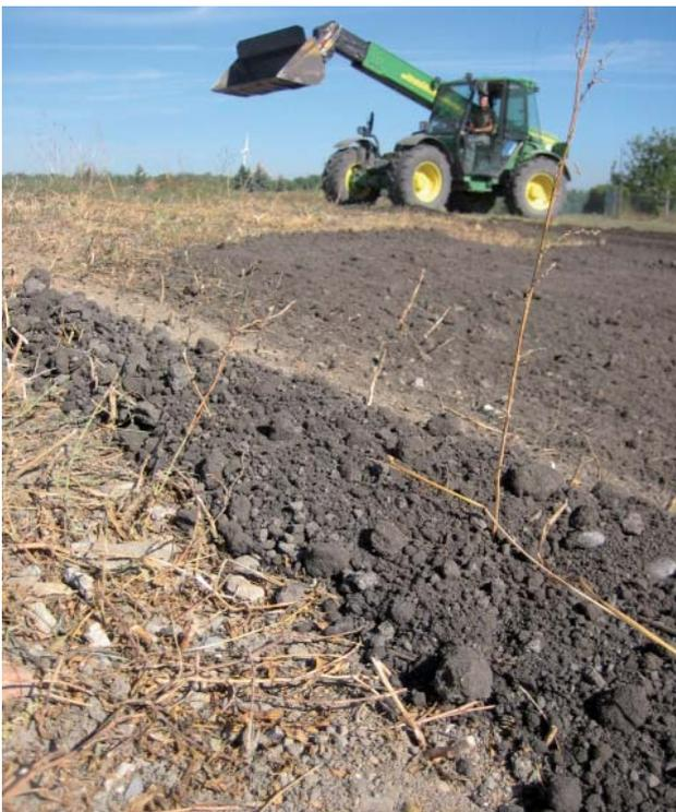
Abbildung 17: Aufbringen einer 3 cm dicken Humusschicht auf den verhärteten, skelettreichen Rohboden [Datum: 9.10.2006]
