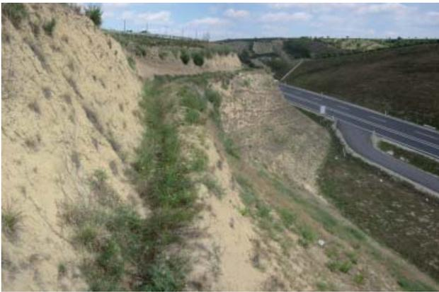
Abbildung 27: S3-westl. Einschnittsböschung, Abschnitt mit Berme und Lockersediment-Steilwänden [Datum: 28.8.2007], Blick nach NNE
