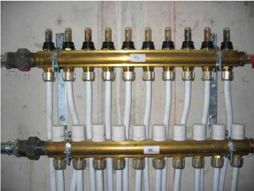
Foto 5: Leitungsverteiler wie im Wohnbau eingesetzt, verfügen über gut regelbare Durchflussmengenbegrenzer
