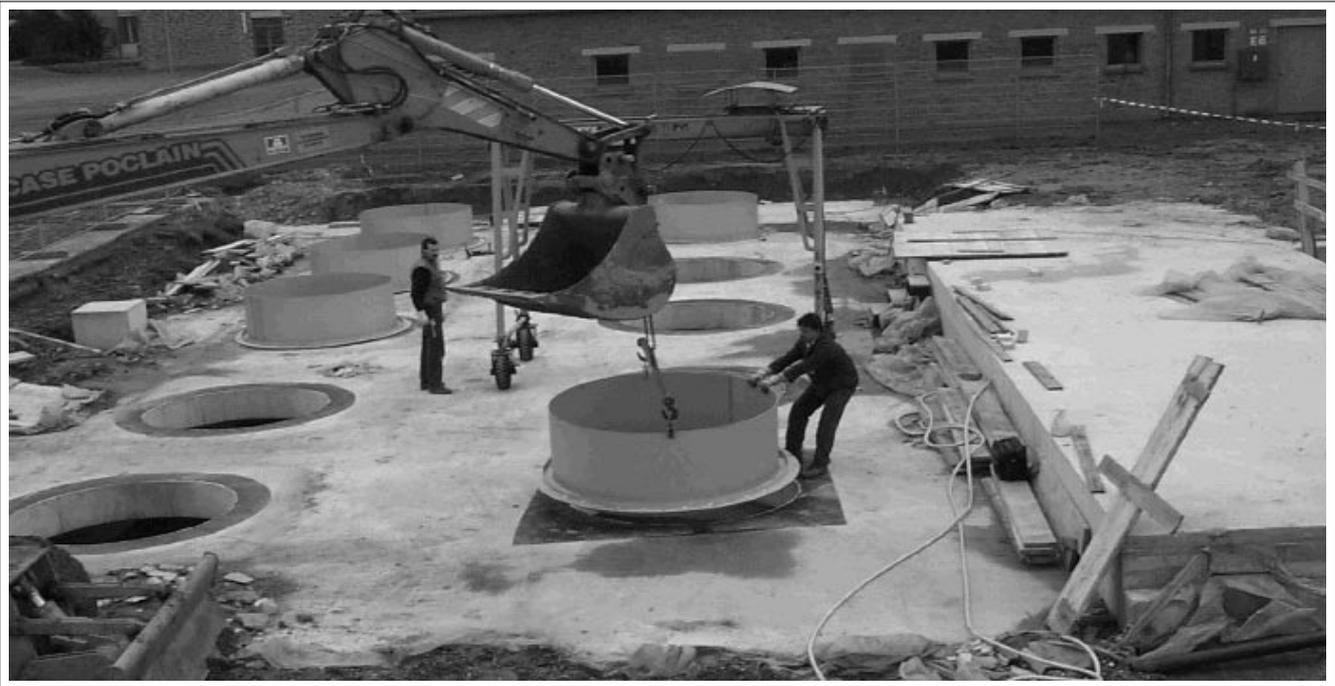
Abbildung 2: Aufsicht auf den Lysimeterkeller während der Bauarbeiten. Montage der Distanzringe auf die Lysimeterpositionen.
