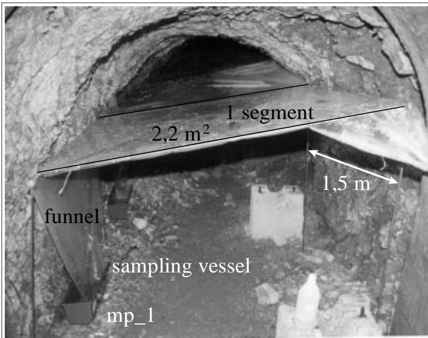
Figure 3: Construction for collecting water samples in the research tunnel. - Probenahmeeinrichtung im Versuchstollen
