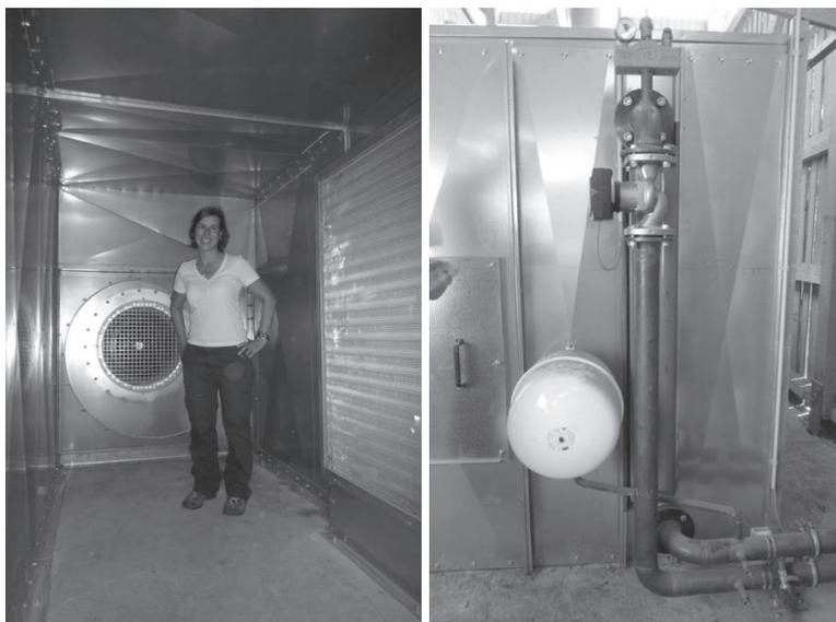
Abbildung 5: Wärmetauscher und Radiallüfter mit KWK-Nutzung
