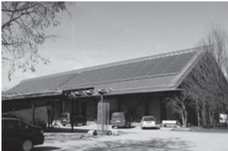
Abbildung 2: Luftkollektoren auf der Trocknungshalle der LfL
