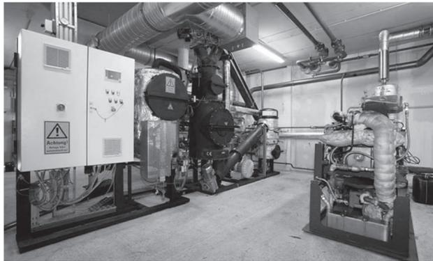
Abbildung 6: Holzgas-Verbrennungsmotor, Firmendarstellung
