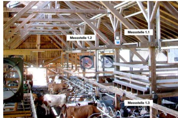
Abbildung 2: Anordnung der Messstellen des Messsystems 1
