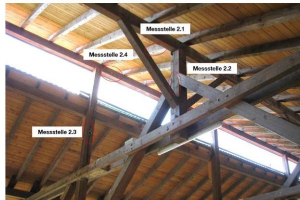
Abbildung 3: Anordnung der Messstellen des Messsystems 2 (Dachkonstruktion)
