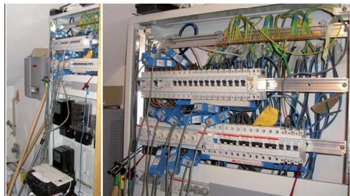
Abbildung 6: Darstellung des Messsystems im praktischen Einsatz an einem Niederspannungsverteiler
