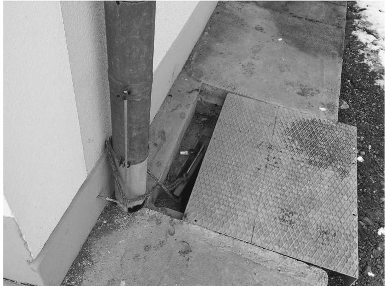
Abbildung 7: Undichter Gülleschieber saugt Frischluft in den Güllebereich
