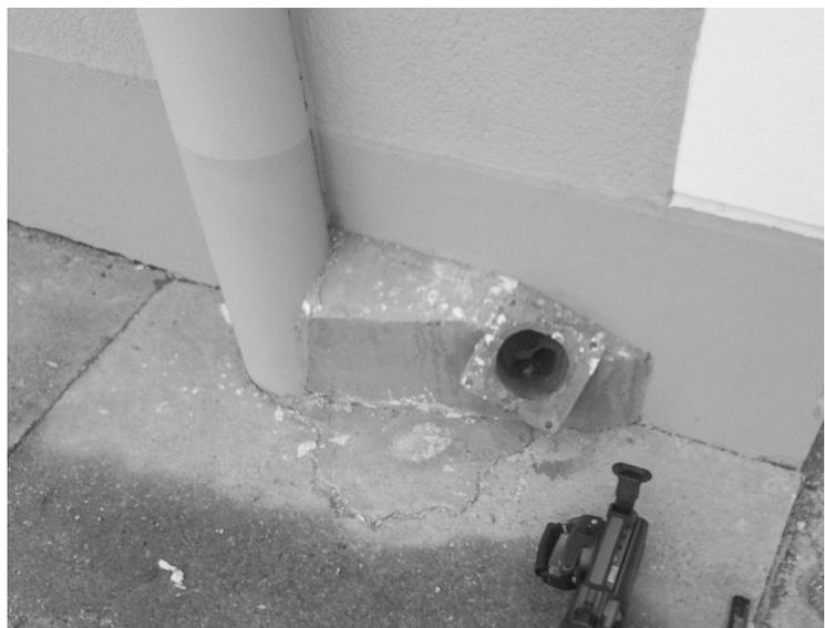
Abbildung 6: Offene Ansaugöffnung an der Außenwand
