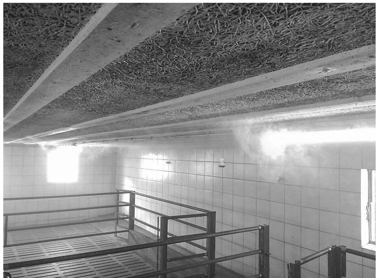
Abbildung 2: Idente Ausführung der Mastphase 2 in allen Abteilen mit Vollspalten und Porenlüftung
