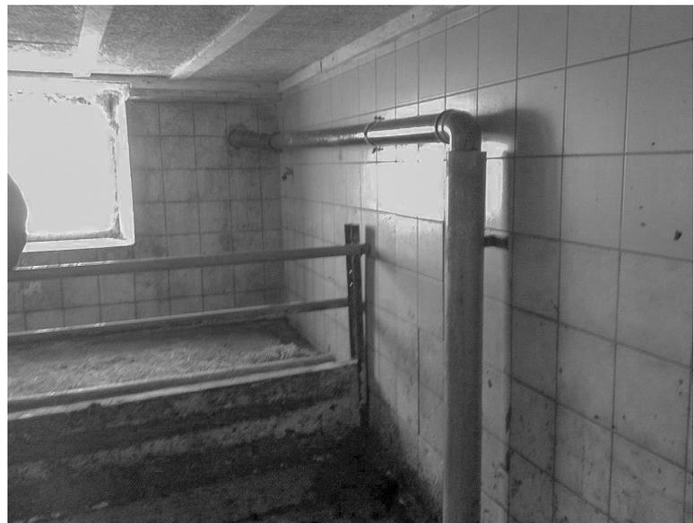
Abbildung 8: Regenwasserleitung in den Güllebereich
