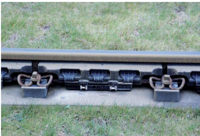
**BILD 6:** Schienenstegbedämpfer (Quelle: Steckler)
