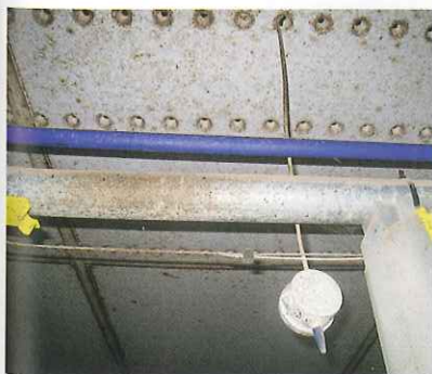
Hier ist der Sensor viel zu hoch und zu nah an den Öffnungen der Lüftungs-decke montiert.
