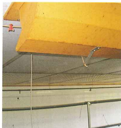
Hier ist der Sensor zwar in der richti-gen Höhe, aber unter dem Sommerluft-Element platziert.
