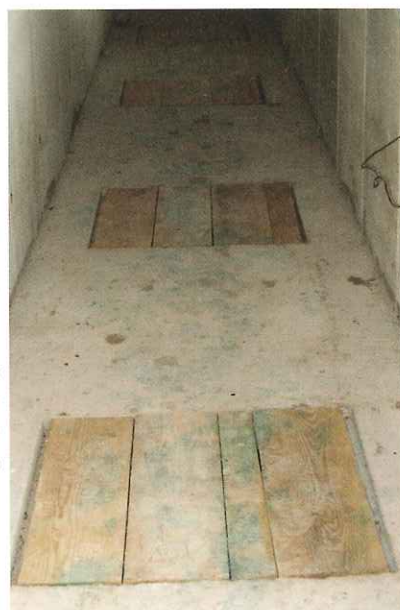
Diese Holzabdeckung ist unzureichend. Schadstoffbelastete Luft gelangt so über die Gülleoberfläche zu den Tieren.
