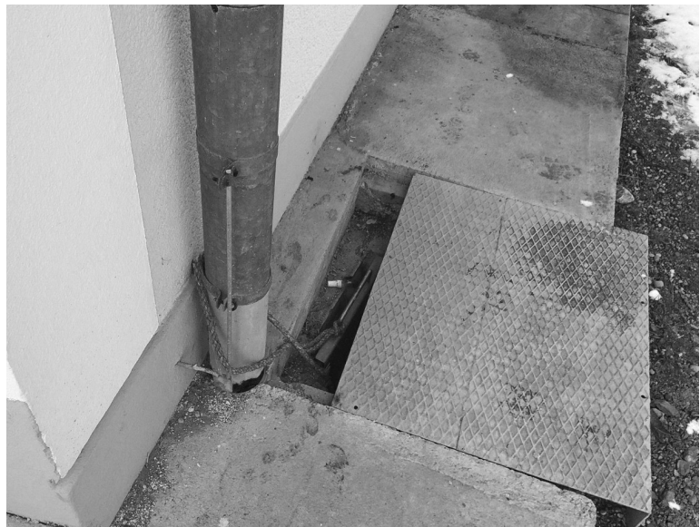
Abbildung 7: Undichter Gülleschieber saugt Frischluft in den Güllebereich
