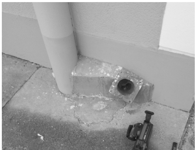
Abbildung 6: Offene Ansaugöffnung an der Außenwand
