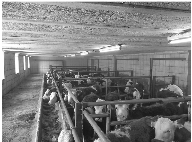
Abbildung 3: „Straßenstall“, ebenfalls mit Porenlüftung und Vollspalten
