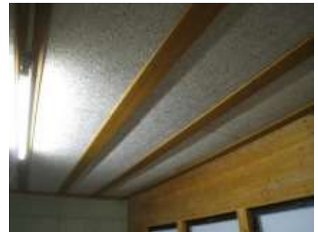
Abb.: Porendecke - funktioniert ohne Heizung
