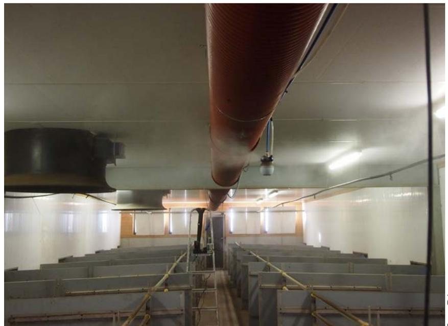
△ Ein von Düsen verteilter feiner Sprühnebel bindet die Staubpartikel im Stall.
