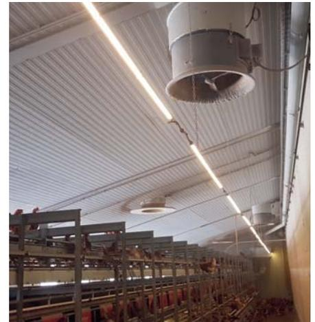
**Bild:** Legehennenstall mit Zu- und Abluftführung über die Stalldecke (Gleichdrucklüftung).
