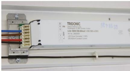
Konverter auf der Rückseite vom Aluträger montiert, Fa Tridonic
