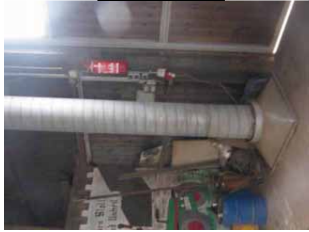
Unterflurabsaugung mit altem Heugebläse
